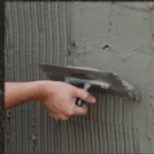
2. Nanošenje ljepila na zid
