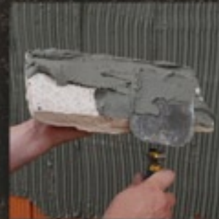
3. Nanošenje ljepila na kamen
